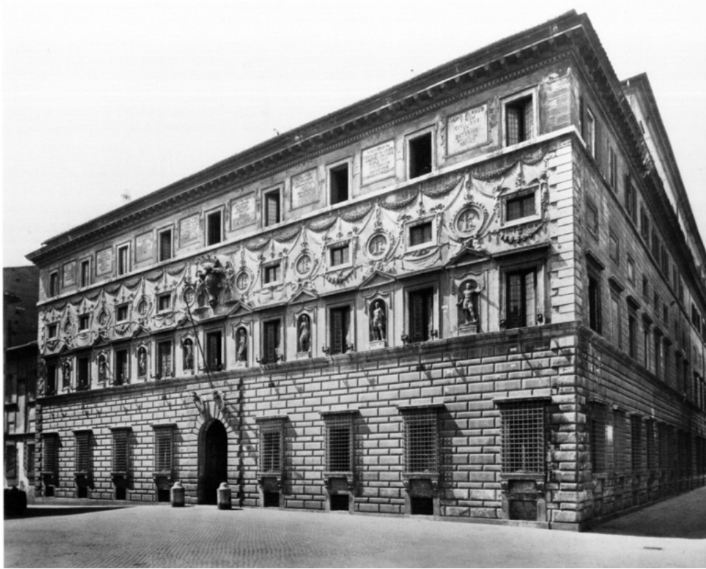
64. Roma, palazzo Capodiferro Spada, facciata
